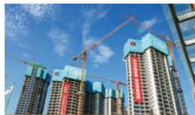
华发水郡花园三期在建工地
